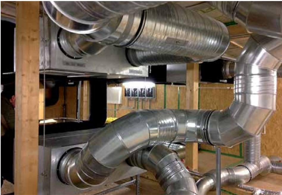
Das Lüftungssystem mit Kanalgeräten und Kreuzstromwärmetauschern geschickt im Dachgeschoss der Halle untergebracht
